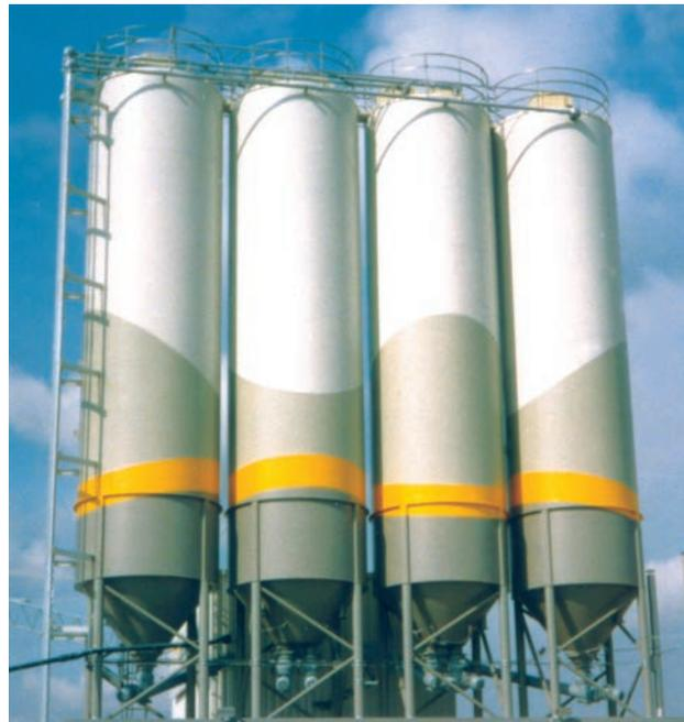
Für schwersauslaufende Medien müssen steilere Konusneigungen verwendet und der Austrag des Schüttgutes durch spezielle Austragshilfen z.B. Stanelle Luftauflockerungen LUALO oder Austragschwingkorb ASK unterstützt werden. Als Zubehör bieten wir verschiedene vorgeschriebene und notwendige Zubehörteile wie Füllleitung, Steigeleiter, Dachrandgeländer, Über- /Unterdruckklappen, Filter, Füllstandsonden, Austragshilfen und Schieber an.
